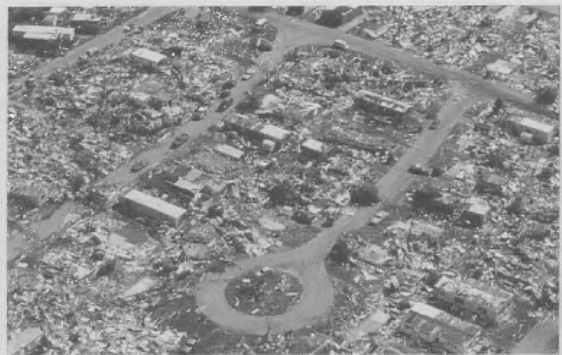
Ein Blick auf die Stadt Cutler Ridge zeigt das Ausmaß der Zerstörung.
