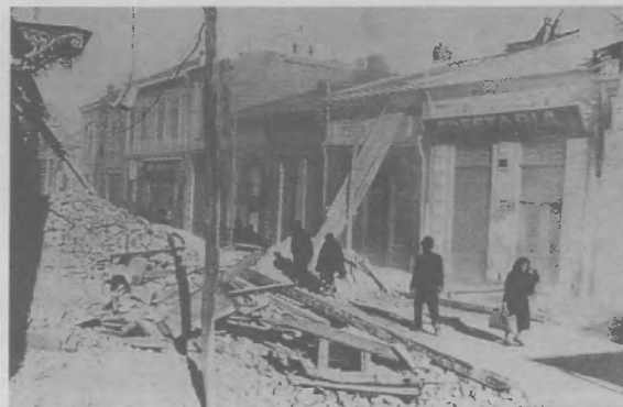
Hauptstraße von Focsani, in dessen Nähe der Erdbeben-Herd lag; von 5560 Häusern wurden hier 2000 vollständig zerstört und 1500 schwer beschädigt
