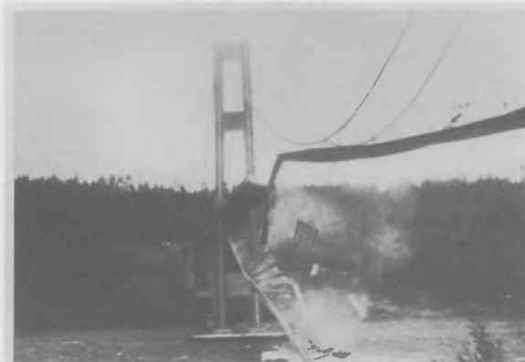
Erste Bewährungsprobe nicht überstanden: Wie eine Streichholzkonstruktion bricht die erst vier Monate alte Tacoma-Narrows-Brücke im Sturm zusammen
