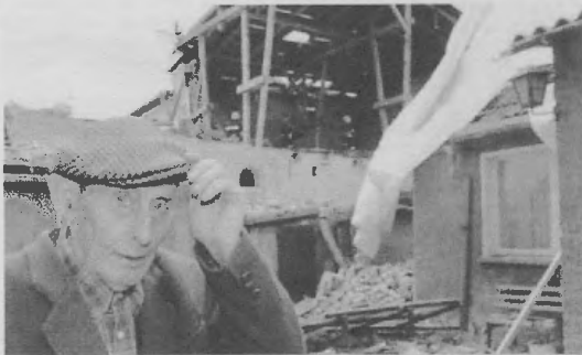
Zerstörtes Haus in Köthen
