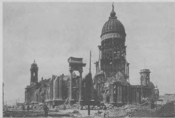
... und danach. Beben und Brände zerstören fast 30 000 Gebäude.
