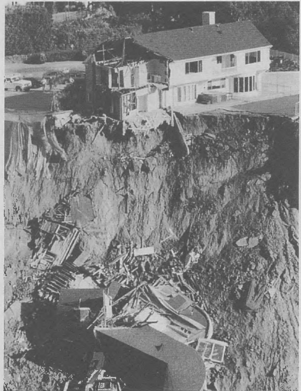
In Pacific Palisades bei Los Angeles ist dieses Wohnhaus bei dem Erdbeben durch einen Erdrutsch zur Hälfte in die Tiefe gerissen worden.
